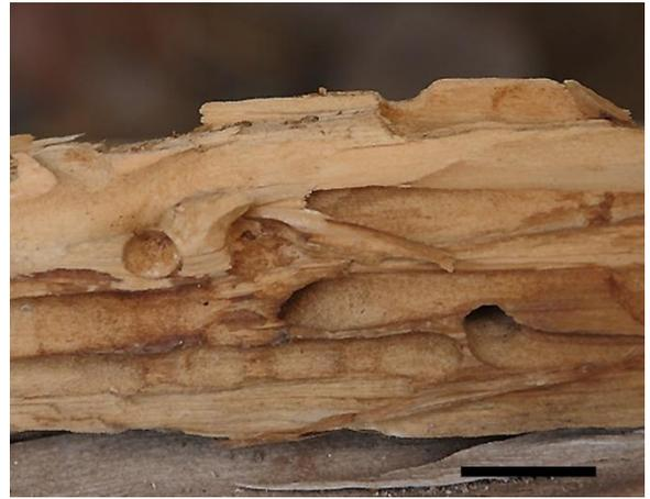
**Figura 7.** Trozo de viga donde se observa el deterioro que producen las abejas *Xilocopa* cuando construyen los túneles y las celdas. Escala 2,5 cm
